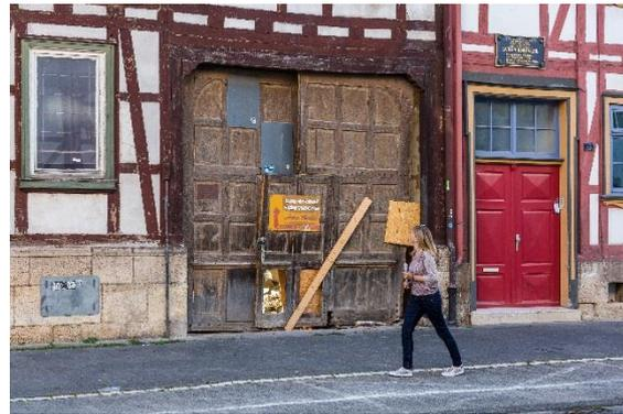
Der zur Straßenseite gewandte Bereich der Fassade, weist starke Schäden auf. Dazu sind Teile der Dacheindeckung abgängig und stellen ein Sicherheitsrisiko bei starkem Wind dar. Im Bereich des Haupteinganges, der auch der Zugang zur rückwärtigen Hofsituation ist, stellt das nur provisorische Tor ein Sicherheitsrisiko dar.
