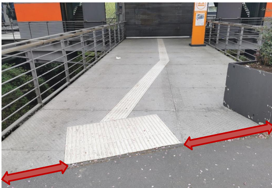
Abbildung 14: Die taktilen Leitsysteme zeigen an einigen Schwebebahn-Haltestellen Lücken in der (ertastbaren) Anbindung an das Umfeld im öffentlichen Straßenraum (Beispiel: Haltestelle Robert-Daum-Platz)
