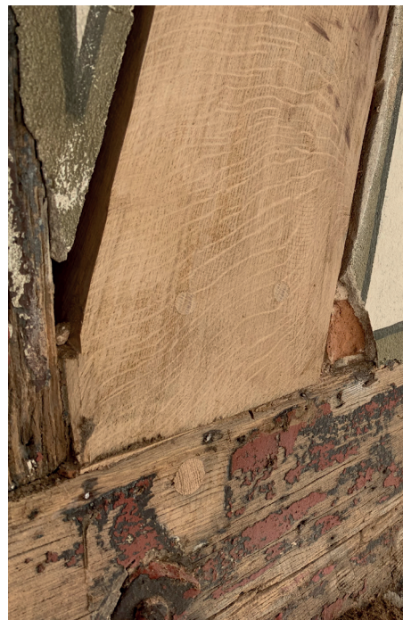
Freilegung und Austausch von Hölzern
