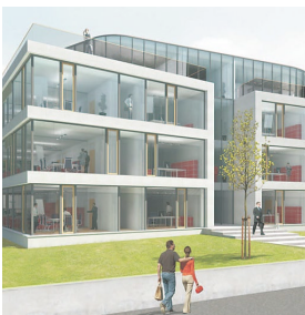
Franz-Tacke-Haus, Quelle: Markus Tacke, GRAI GmbH Architekturteam Interdisziplinär
