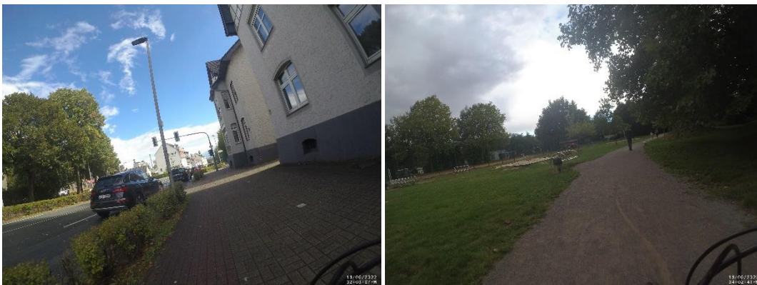
Abbildung 56: Pflastersteine (links) und Wassergebundene Decke (rechts)
