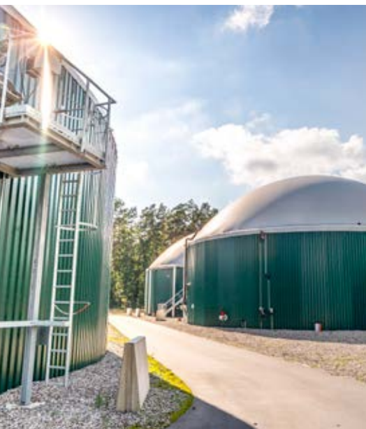
Hightech im ländlichen Raum: Bioethanol-Anlage Torgelow
