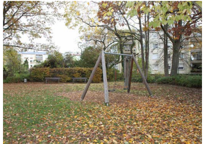
Foto 25: Nicht eingezäunter Bereich des Spielplatzes
