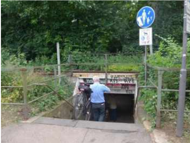
Abbildung 42 - Fehlende Barrierefreiheit an einer Bahnunterführung (Bild: faktorgruen).
