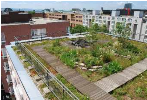
Abbildung 112 - Das Umweltamt der Stadt Karlsruhe geht mit gutem Beispiel voran: Kombination aus intensiver und extensiver Dachbegrünung (Bild: Umweltamt Karlsruhe, Optigrün international AG).
