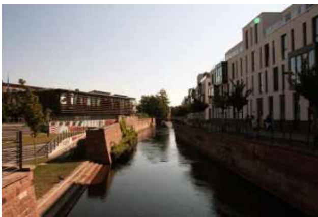
Abbildung 32 - Zugänglichkeit der Queich im Bereich Heinrich-Heine-Platz (Bild: faktorgruen).
