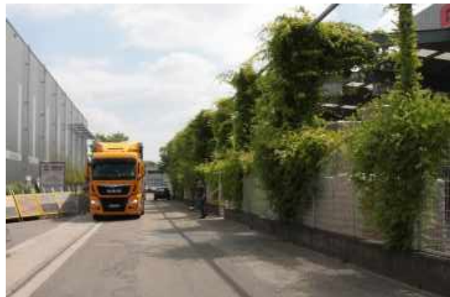
Abbildung 58 - Begrünte Überdachung eines Baumarktes (Bild: faktorgruen).
