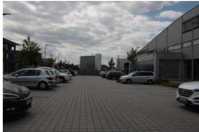
Abbildung 62 - Flächenbefestigung mit offenen, wasserdurchlässigen Fugen (Bild: faktorgruen).
