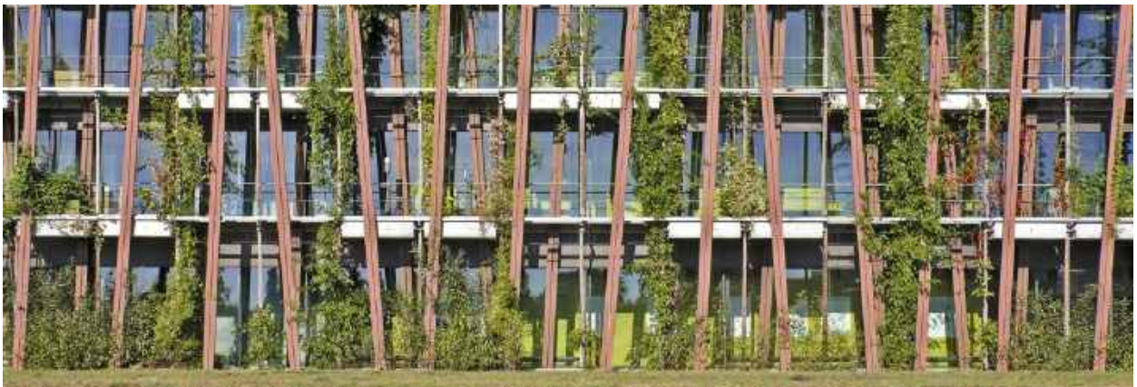
Abbildung 137 - Große Fensterfronten können durch vorgelagerte Fassadenbegrünung verschattet werden. Im Winter werden solare Wärmegegewinne zugelassen (Bild: Institut für Physik der Humboldt-Universität zu Berlin, Prof. Dr. Nicole Pfoser, HfWU Nürtingen, Kompetenzzentrum für Gebäudebegrünung und Stadtklima e.V.).
