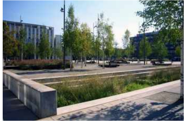
Abbildung 104 - Retention von Regenwasser im Gewerbegebiet – ein wichtiger Baustein des nachhaltigen Regenwassermanagements (Bild: faktorgruen).
