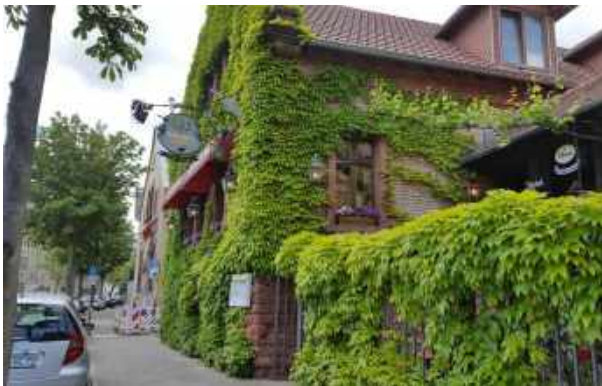
Abbildung 114 - Fassadengebundene Begrünung in Landau (Bild: Stadt Landau).
