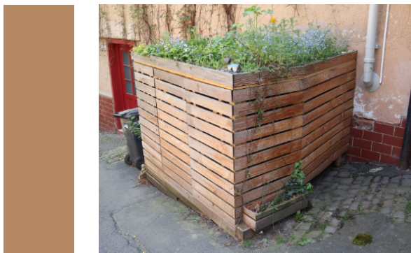
Mülleinhausung mit Substratdach (privat)
