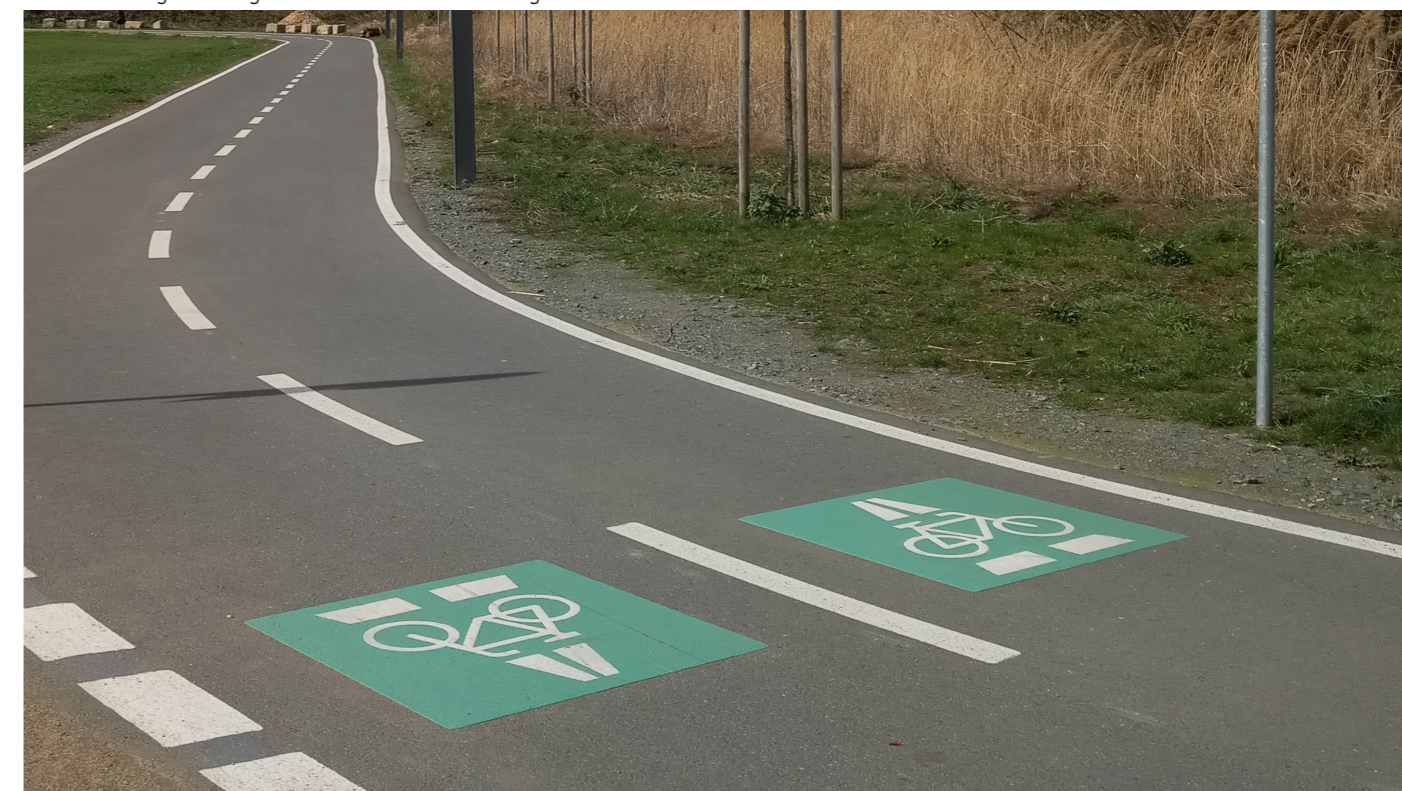
Bauliche Ausgestaltung einer Radschnellverbindung
