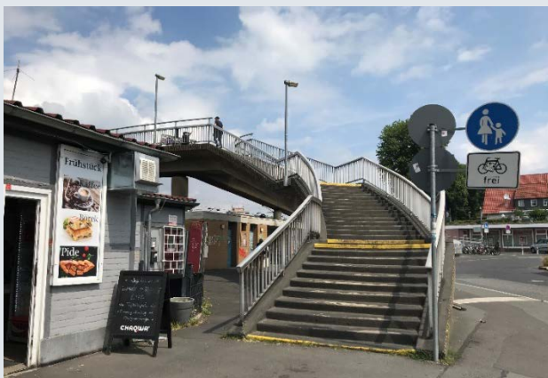
Zugang vom Bahnhofsvorplatz
