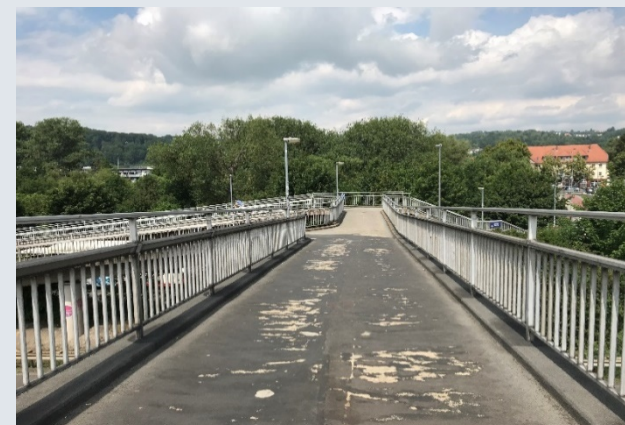
Auf der Personenüberführung / „Am Krekel“
